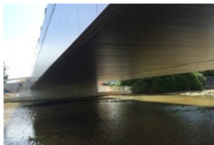
多機能防食デッキ適用橋の断面と事例写真
