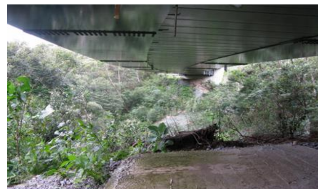
主桁直下(多機能防食デッキ設置状況)
