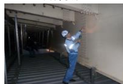
多機能防食デッキ適用橋の断面と事例写真
